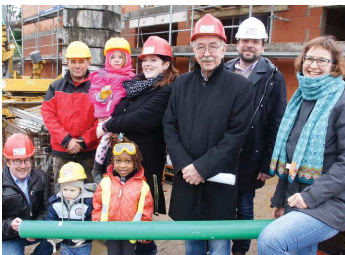
Besichtigten mit Kindern der Kita Orionstraße die Baustelle: (v.l.n.r.) Bezirksbürgermeister Mike Bartels, Polier Michael Hübner, Alexandra Sell, Jan Brautmeier, Frank Horn und Claudia Köhler.
