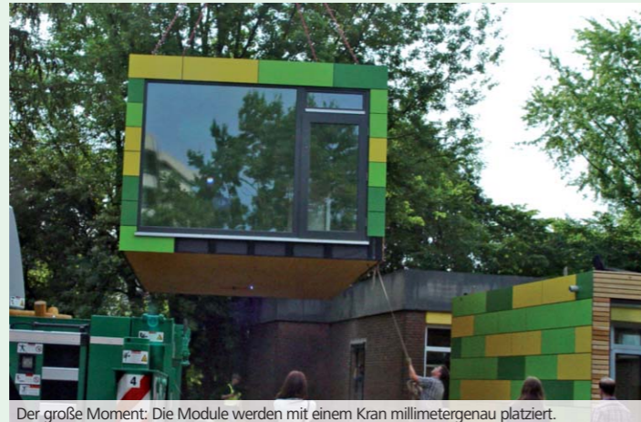
Der große Moment: Die Module werden mit einem Kran millimetergenau platziert.
