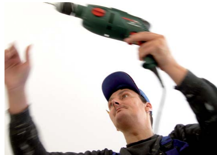
Geht wie Butter: Ralf Rothe bohrt gekonnt und mit Konzentration ein Loch in die Wand.
